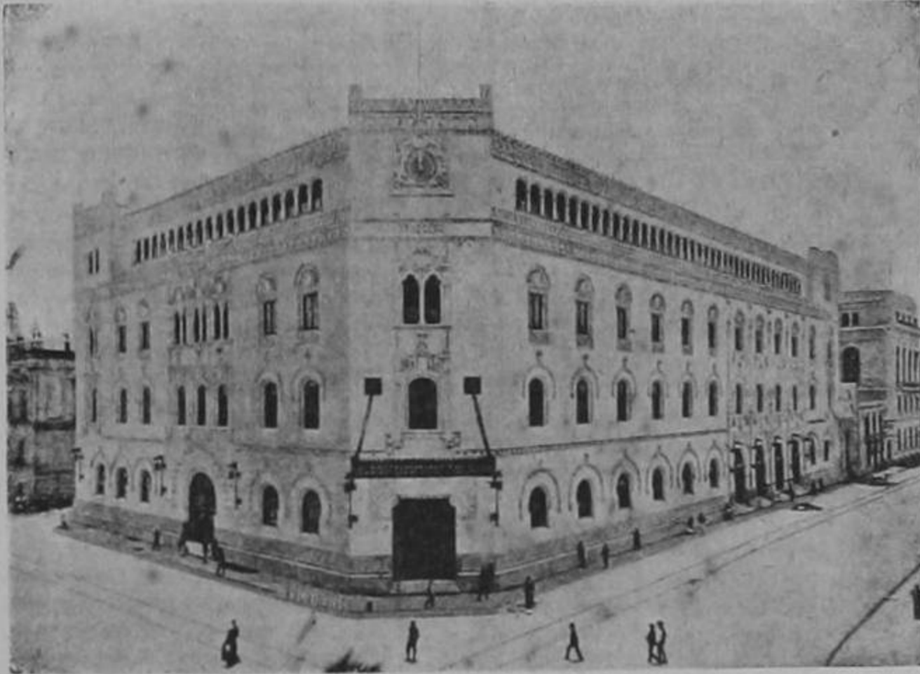
Edificio de Correos
